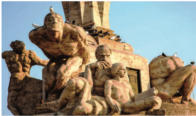
Figura 85. Foto de las estatuas de la Plaza de armas en Perú. Es visible el daño ocasionado por las heces de las aves
